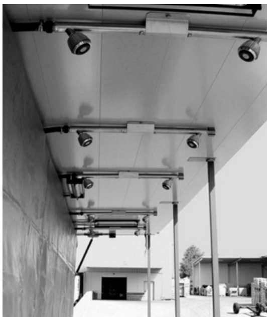
Рис. 24. Варіанти вибору душу під час санітарної обробки (дезактивації) людей
