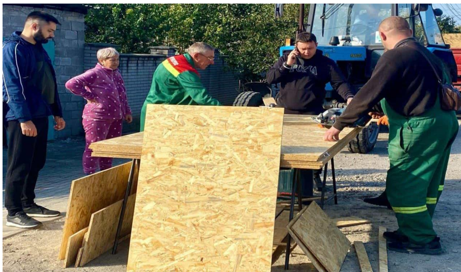
Фото: Відбудова. Запоріжжя
