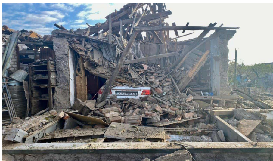
Фото: Відбудова. Запоріжжя
