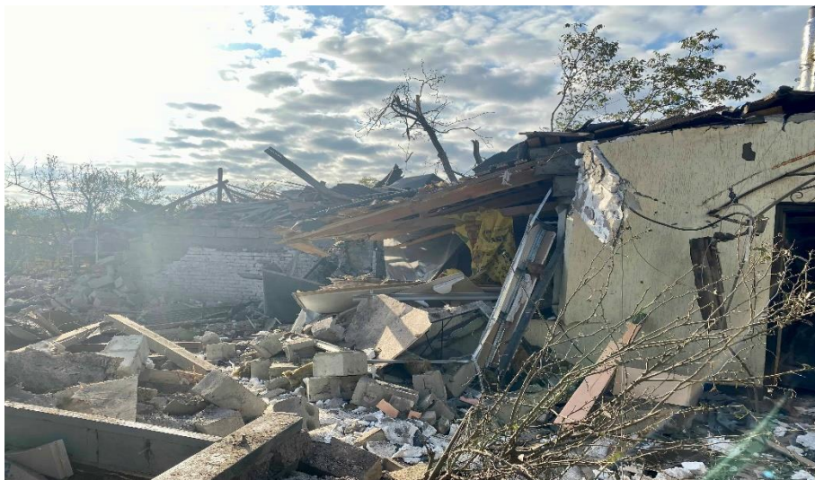
Фото: Відбудова. Запоріжжя
