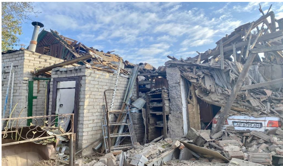
Фото: Відбудова. Запоріжжя
