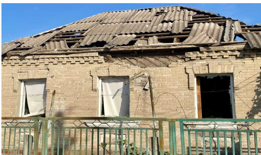
Фото: Відбудова. Запоріжжя
