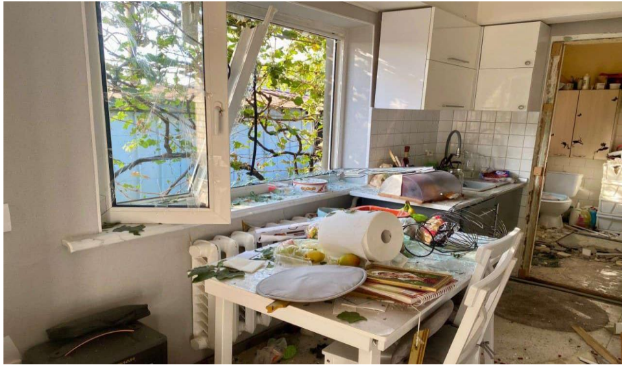
Фото: Відбудова. Запоріжжя
