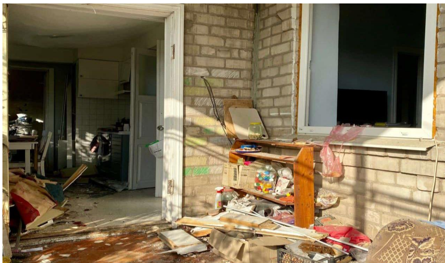
Фото: Відбудова. Запоріжжя
