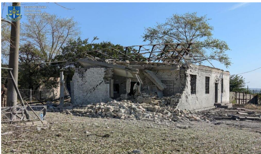
Фото: Запорізька обласна прокуратура
