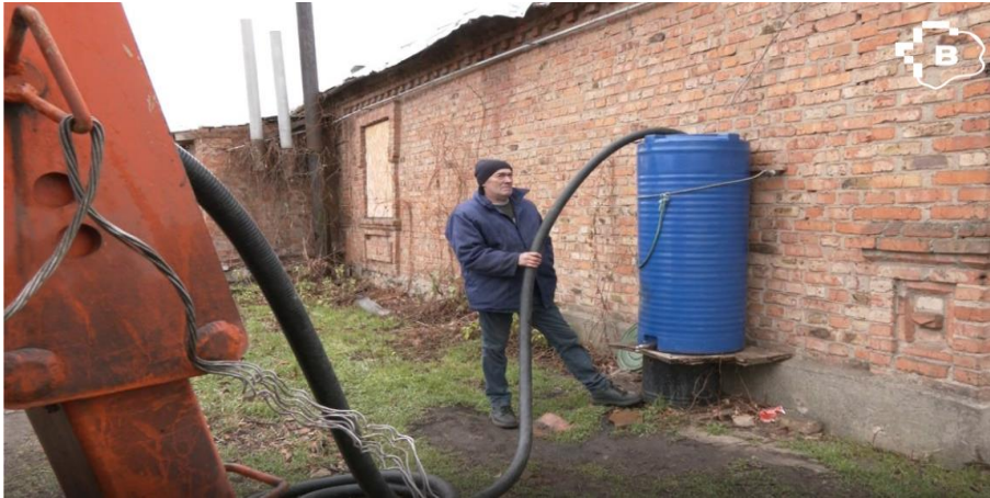
Фото: Відбудова. Запоріжжя
