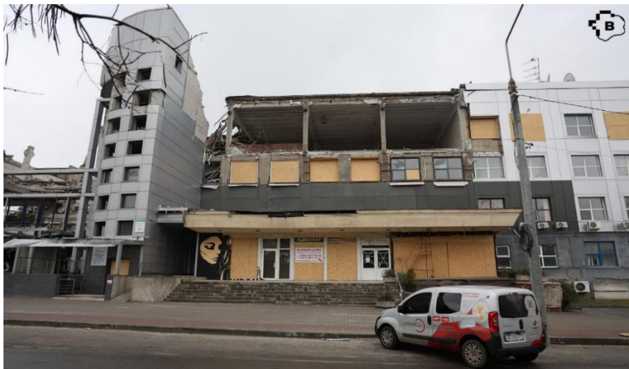
Фото: «Відбудова. Запоріжжя»
