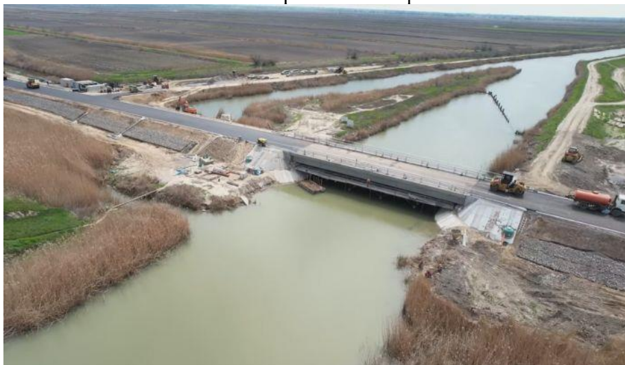
Міст через канал Кофа
